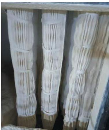
Рис. 6. Рукавный фильтр после модернизации
