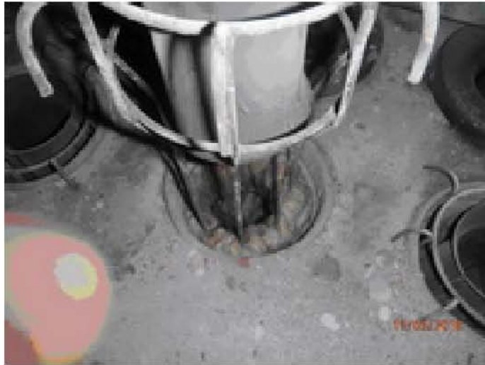
Рис. 7. Осмотр фильтровального рукава
