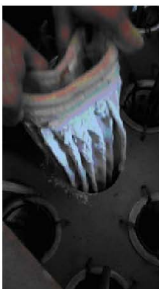
Рис. 10. Демонтаж рукава 3DESA фильтрпатрон
