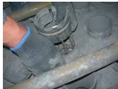
Рис. 6. Установка новых рукавов
